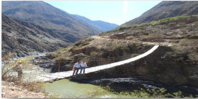
Zona de emplazamiento del puente Challhuan
