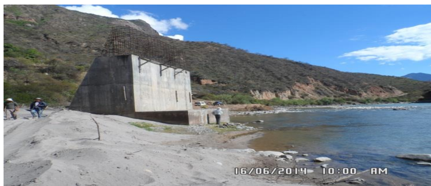
Estructura (Estribo izquierdo) existente en la zona de intervención
